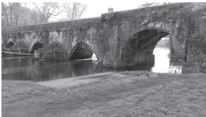
Ponte sobre o río Miño no lugar da Ponte (Rábade)
