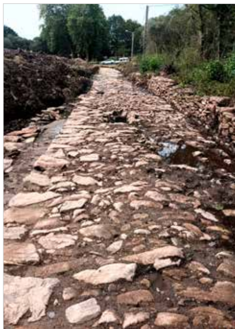
Tramo de calzada escavado en setembro de 2023, á entrada da ponte vella de Brandomil
